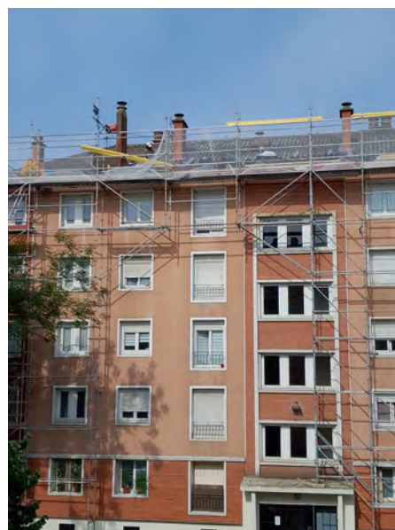
Réfection de la toiture escaliers 9/10 Résidence Rosenberg à Vitry - Montant : 431 489,33 euros TTC
