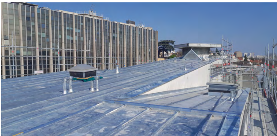
Couverture Cité de l'église à Arcueil : renouvellement complet, étanchéité, orientation des pentes d'écoulements, 354 K€ HT ; renouvellement du système désenfumage et installation de garde-corps
