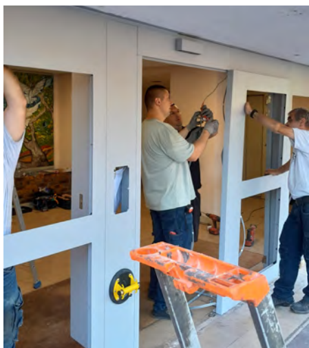
Remplacement de l'éclairage (Montant 36 15,04€ TTC) et de la porte coulissante (Montant 29 720€ HT) au 17 rue du Val de Marne à Gentilly
