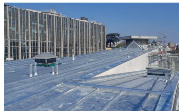
Valdevy a procédé de janvier à juin à la réfection de la couverture du bâtiment 42-46 rue Émile Raspail (38 logements). **Un renouvellement complet de la couverture zinc traditionnelle** a été réalisé, et les pentes d'écoulement des eaux ont été accentuées afin de remédier aux problèmes d'infiltration d'eau.
